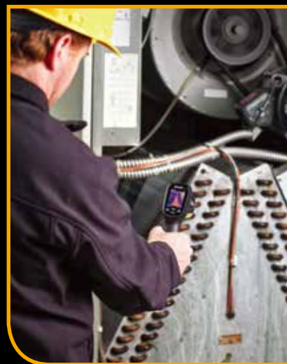
暖通空调(HVAC)检查
