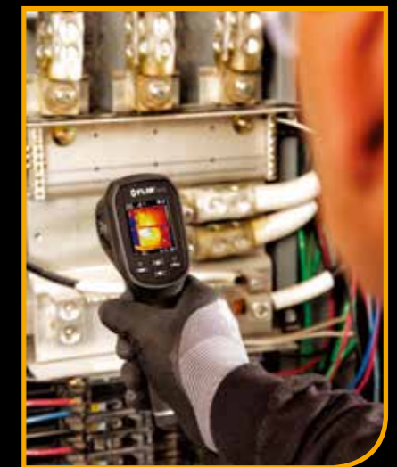
电气故障检修
